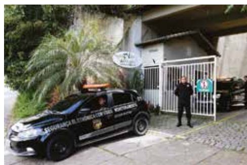
CONDOMÍNIO ALTO DE PENDOTIBA
